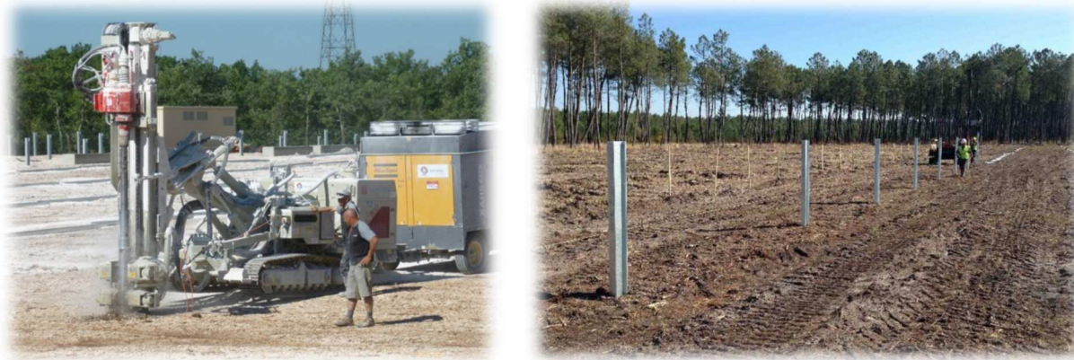
Ancrage au sol par pieux battus
